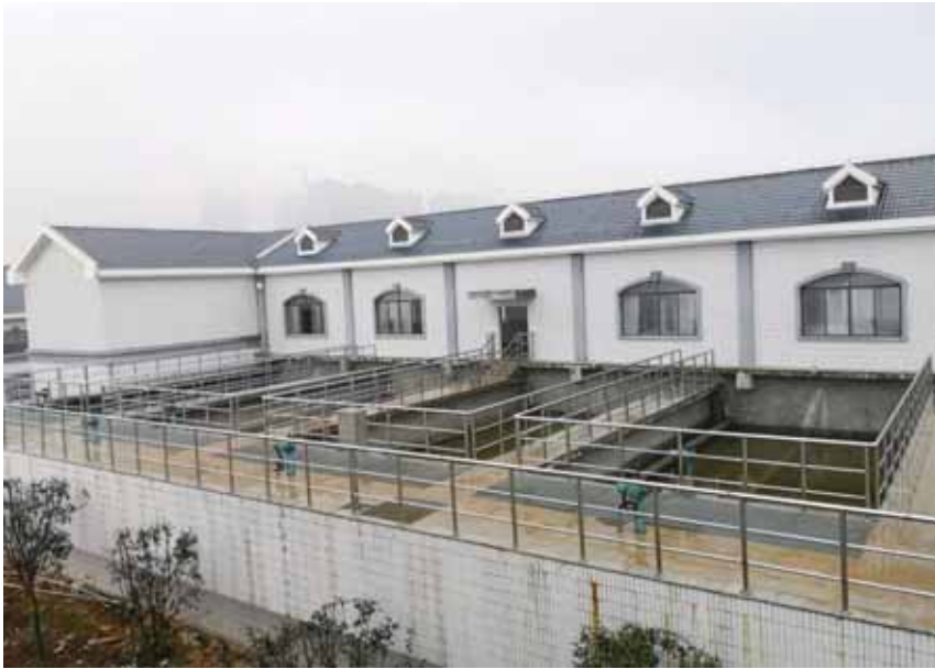
铜桥港污水处理厂
