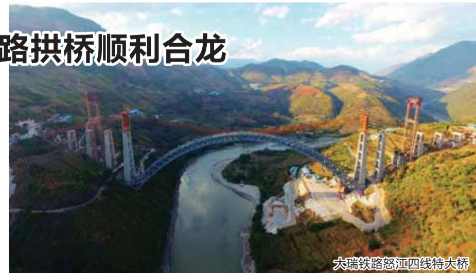
原的峡谷，受环境和地形的限制，怒江车站只能建在桥上。同时受高烈度地震带影响，桥梁的宽度和承载力远远超过普通铁路桥梁，建设这样超大跨度、超大规模的四线车站桥，在世界铁路桥梁史上没有先例。
