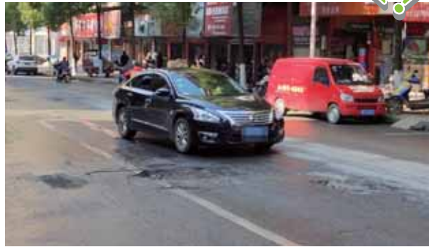
过往车辆减速绕过坑洞
