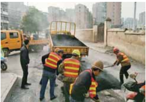
施工人员加紧垫铺沥青
