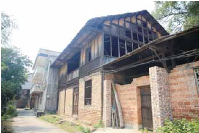
以竹篾为墙的老建筑
