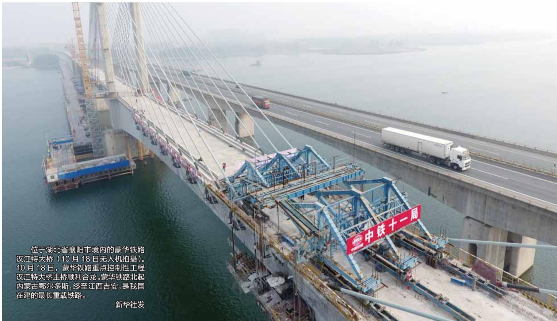
位于湖北省襄阳市境内的蒙华铁路汉江特大桥（10月18日无人机拍摄）。10月18日，蒙华铁路重点控制性工程汉江特大桥主桥顺利合龙。蒙华铁路北起内蒙古鄂尔多斯，终至江西吉安，是我国在建的最长重载铁路。
