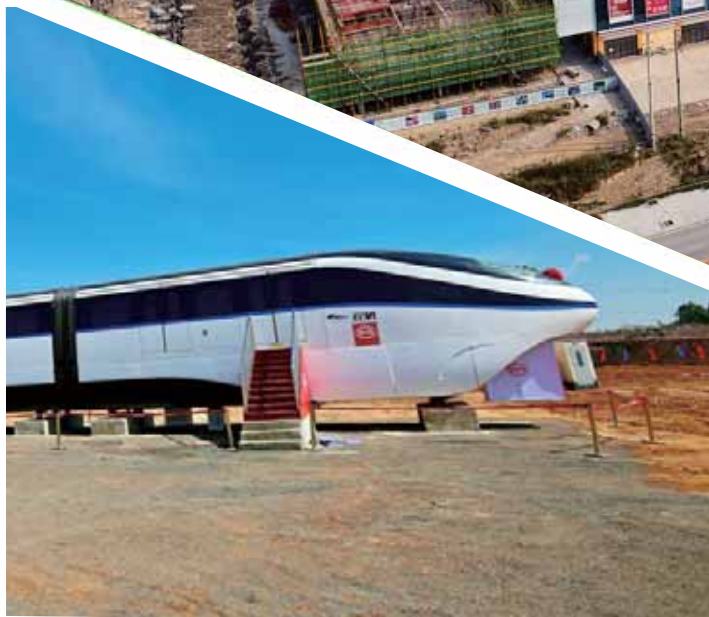
比亚迪（衡阳）轨道交通智能制造产业园项目
