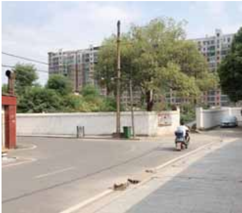
小区及道路两旁均没有路灯
