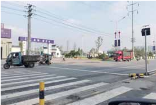
蒸湘南路一排隔离桩疑遭人为破坏
