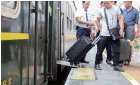
站台加高后,大大减小了站台与车厢进出口的间隙
