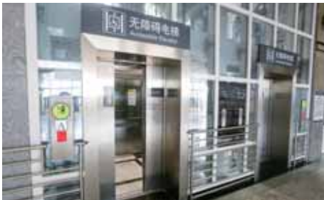
候车厅还提供两台无障碍电梯
