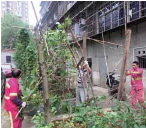
工作人员正在拆除藤架
