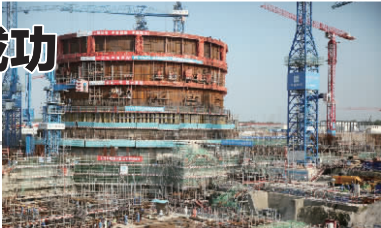
广西防城港核电项目3号机组
