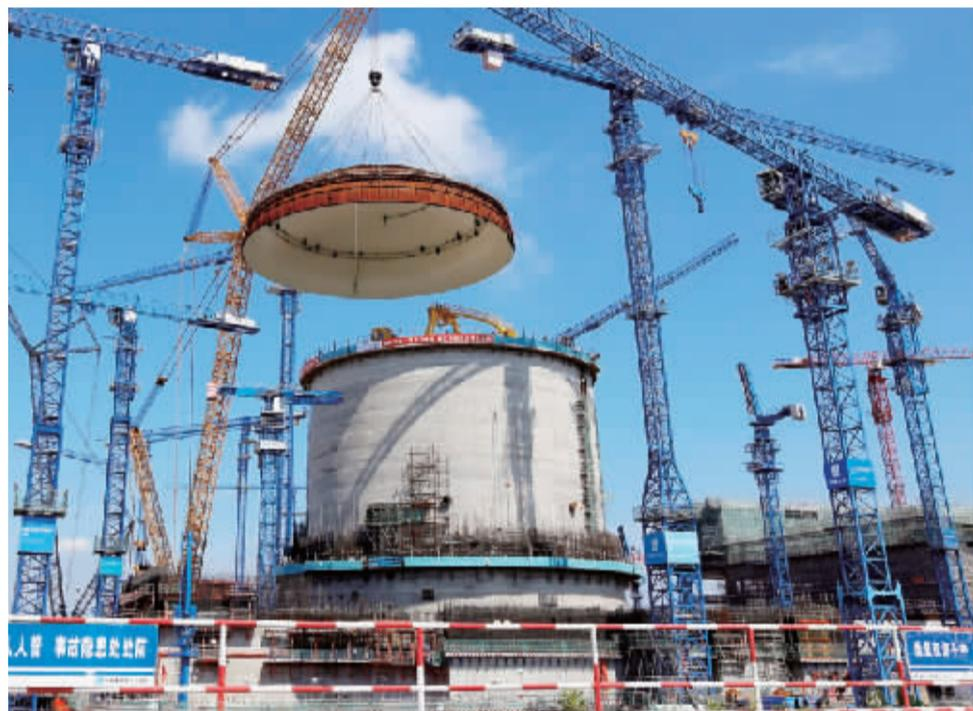
中国广核集团 23 日对外通报表示，我国自主三代核电“华龙一号”示范项目——中广核防城港核电二期工程 3 号机组穹顶吊装顺利完成，这标志着作为英国“华龙一号”核电项目参考电站的防城港 3 号机组从土建施工阶段全面转入设备安装阶段，为进一步高质量稳步推进工程建设奠定了基础。
