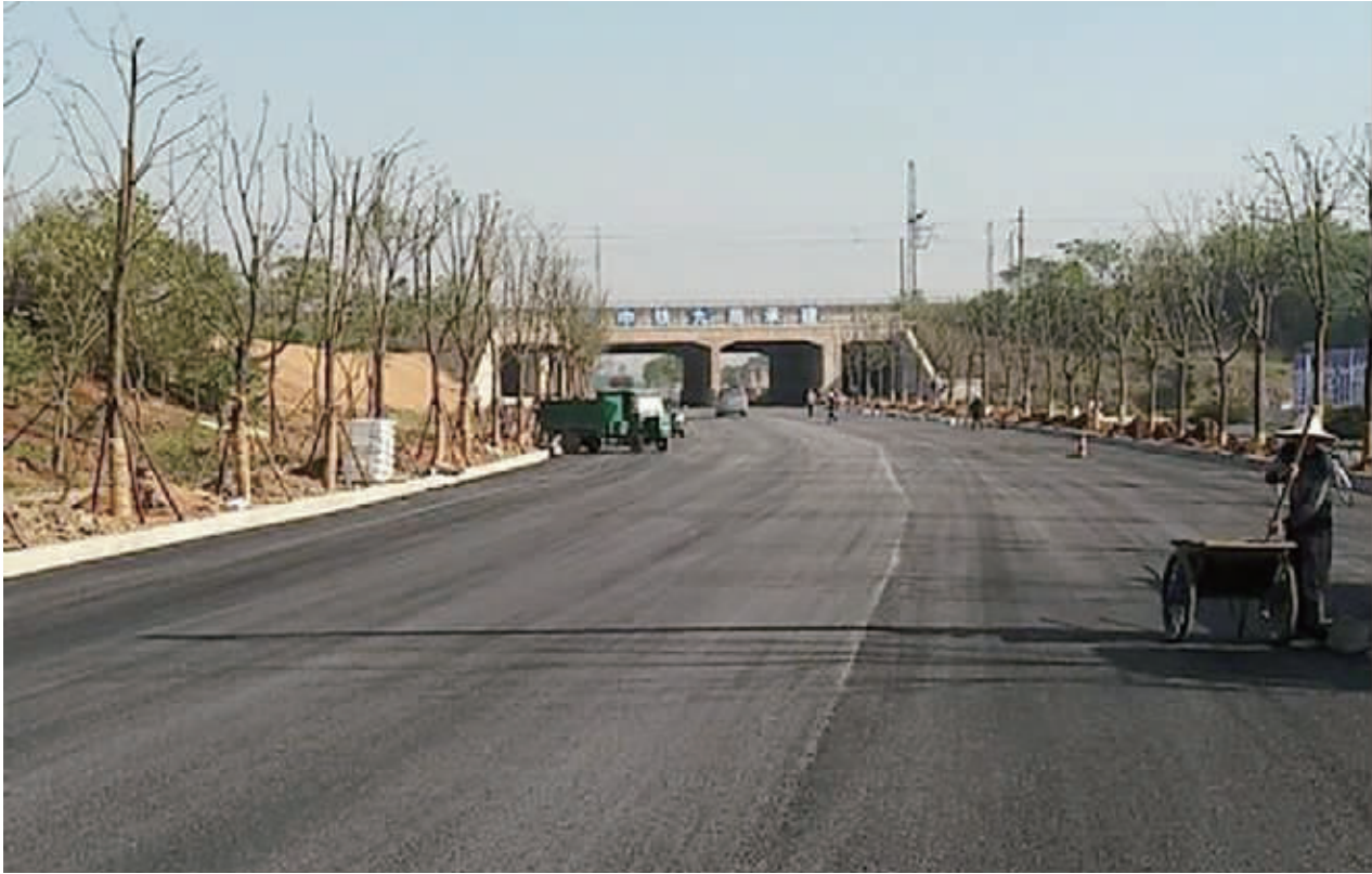
路面沥青铺设完毕
