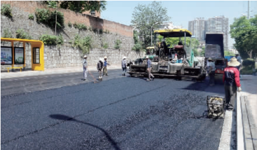
施工机械进场摊铺沥青
