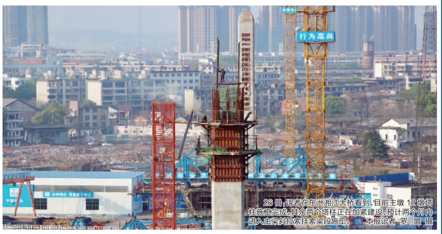
26日，记者在东洲湘江大桥看到，目前主墩12墩塔柱施工完成，其余两个塔柱正在加紧建设，预计两个月内进入主梁斜拉索挂索梁段施工。 本报记者 罗盟 摄
