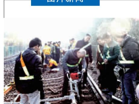
近年来，广铁工务大修段加大了对线路机械更新投入力度，实现了施工作业标准化、流程可视化、设备现代化，提高了工作效率，确保了职工队伍稳定。图为在练兵场上，检验员工操纵内燃除锈机时的情景。
