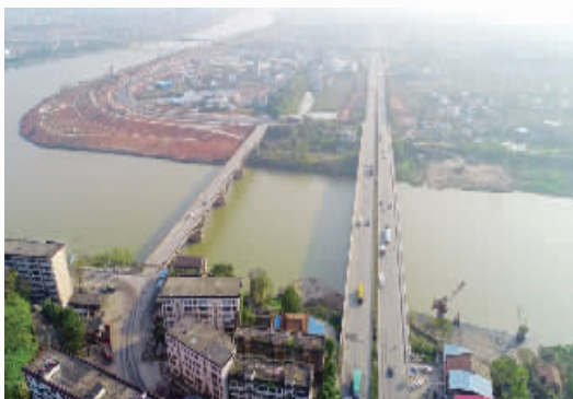
酃茶大桥横跨耒水
