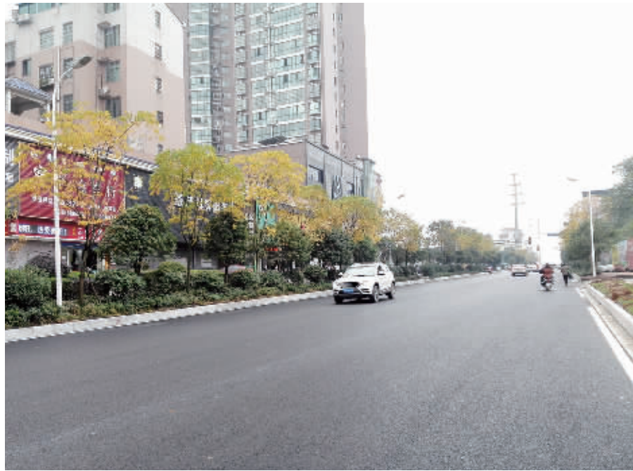
改造后的道路焕然一新
