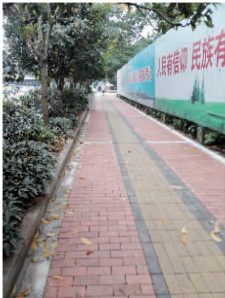
新铺透水砖的人行道
