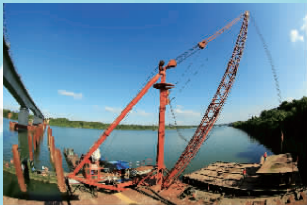
跨湘江特大桥正在撤除水下铁柱
