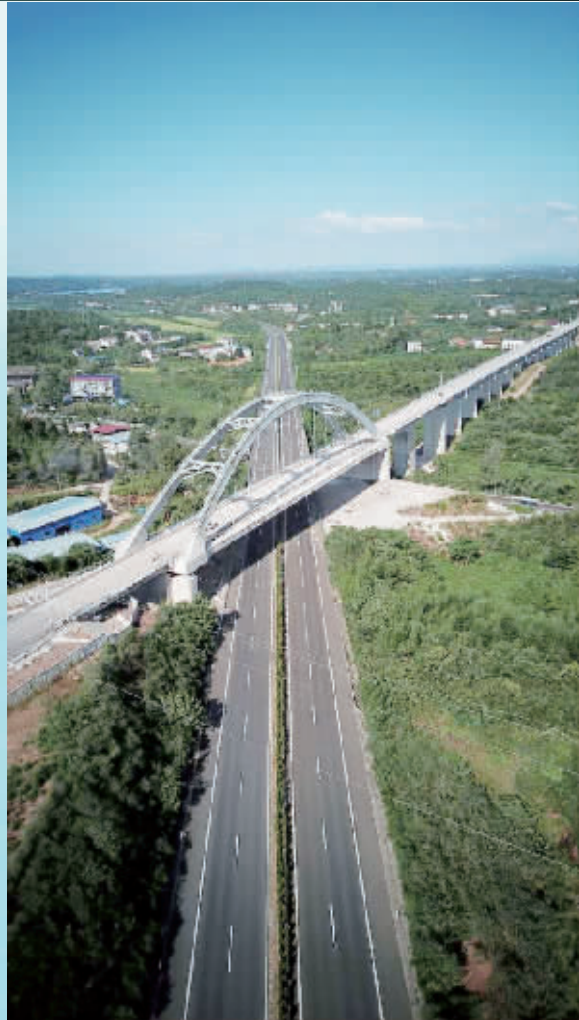
跨京港澳高速公路特大桥
