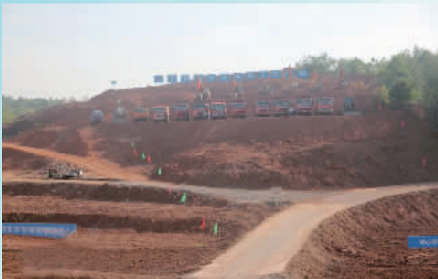
8 月 25 日,怀邵衡铁路西渡站配套设施项目开工(资料图)
