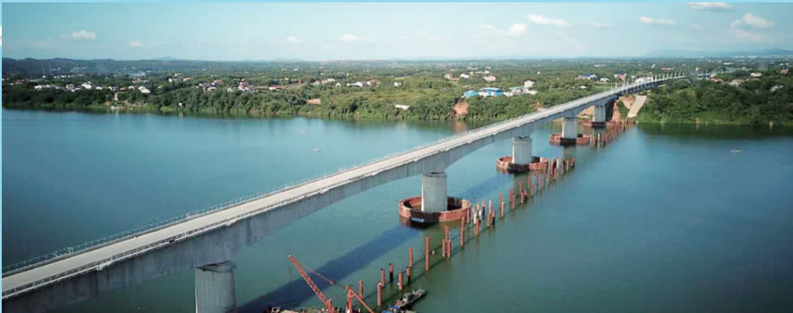
跨湘江特大桥
