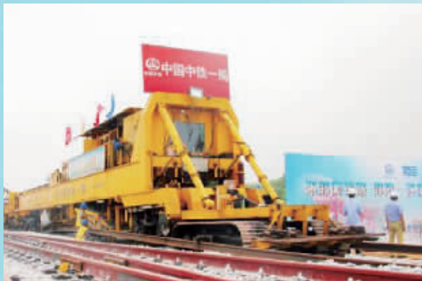
邵阳往怀化方向正在铺轨(资料图)
