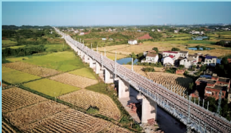
衡阳县段已经完成铺轨的路段
