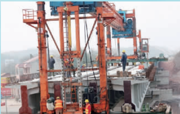
铁路施工照(资料图)
