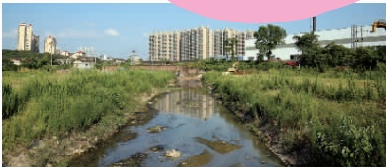
蒸湘区段已完成河道平整
