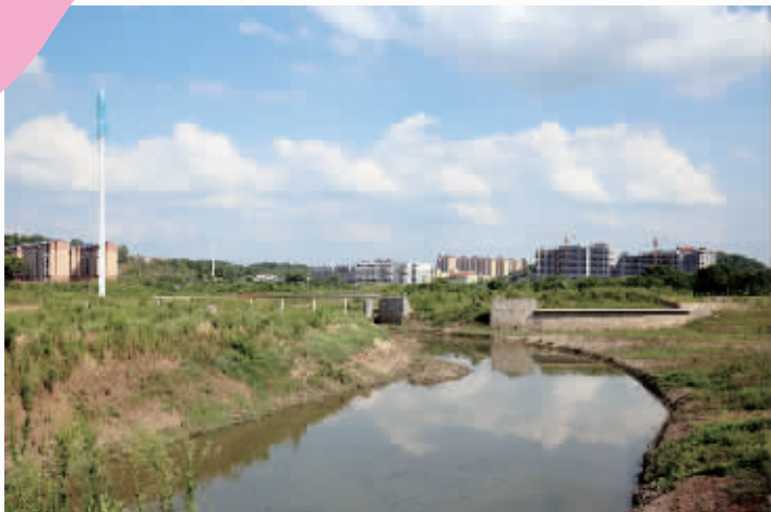
工程量完成近半
