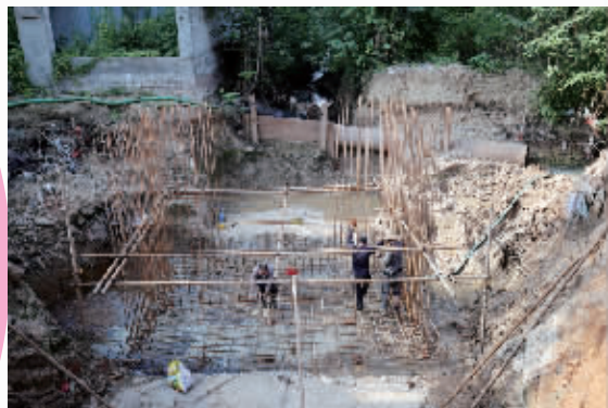
北塘段污水截流井施工中
