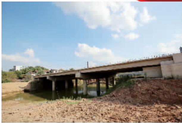
燕京桥段工程正在施工
