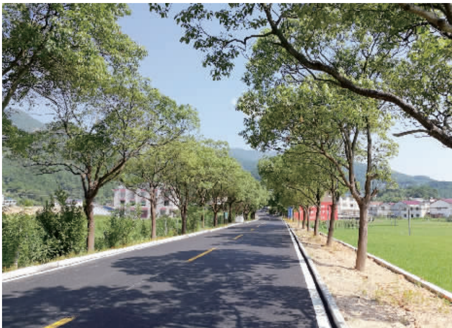
图为修整改造后的南岳水濂洞景区公路
