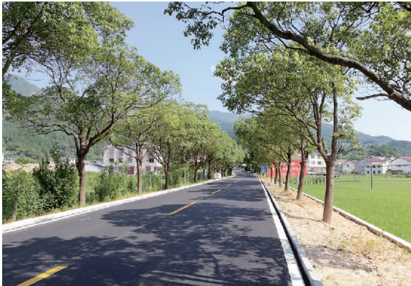
图为修整改造后的南岳水濂洞景区公路
