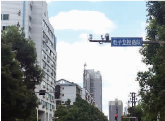
市区反向电子警察正在安装调试中
