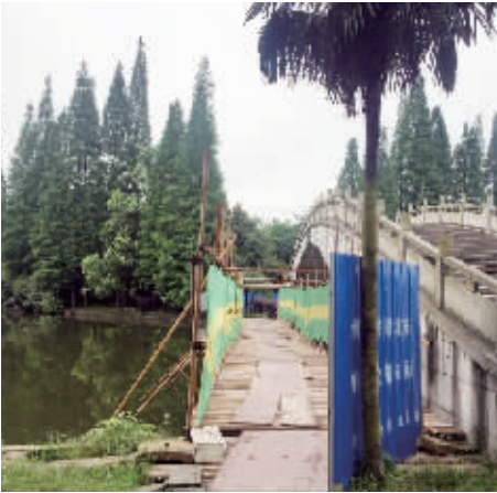
石拱桥旁的施工便道
