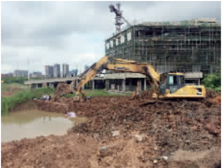
住建部门正在修筑一道13米高的子堤
