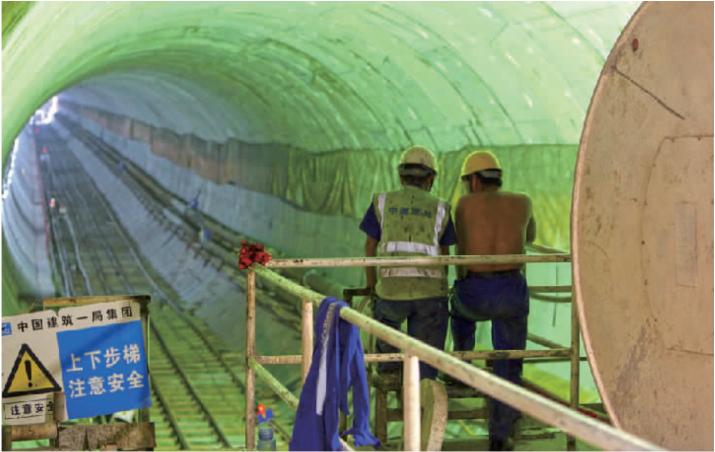
穿过最低点,盾构机开始“爬坡”掘进。
