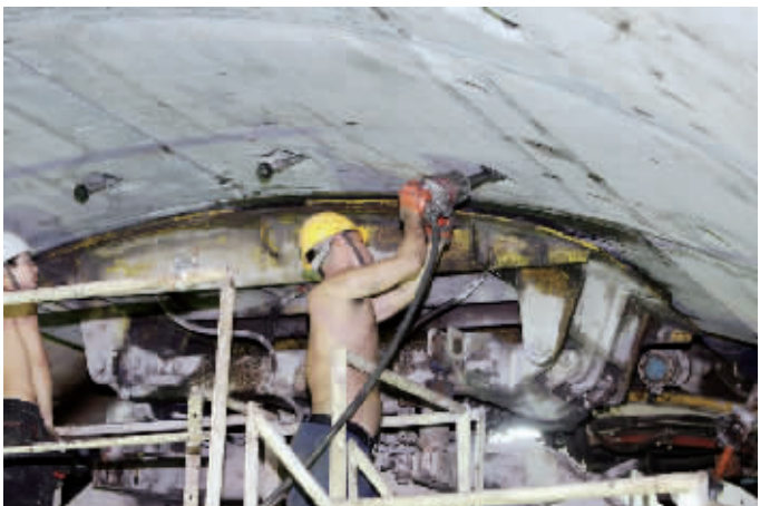
拼装管片后,用螺栓紧固
