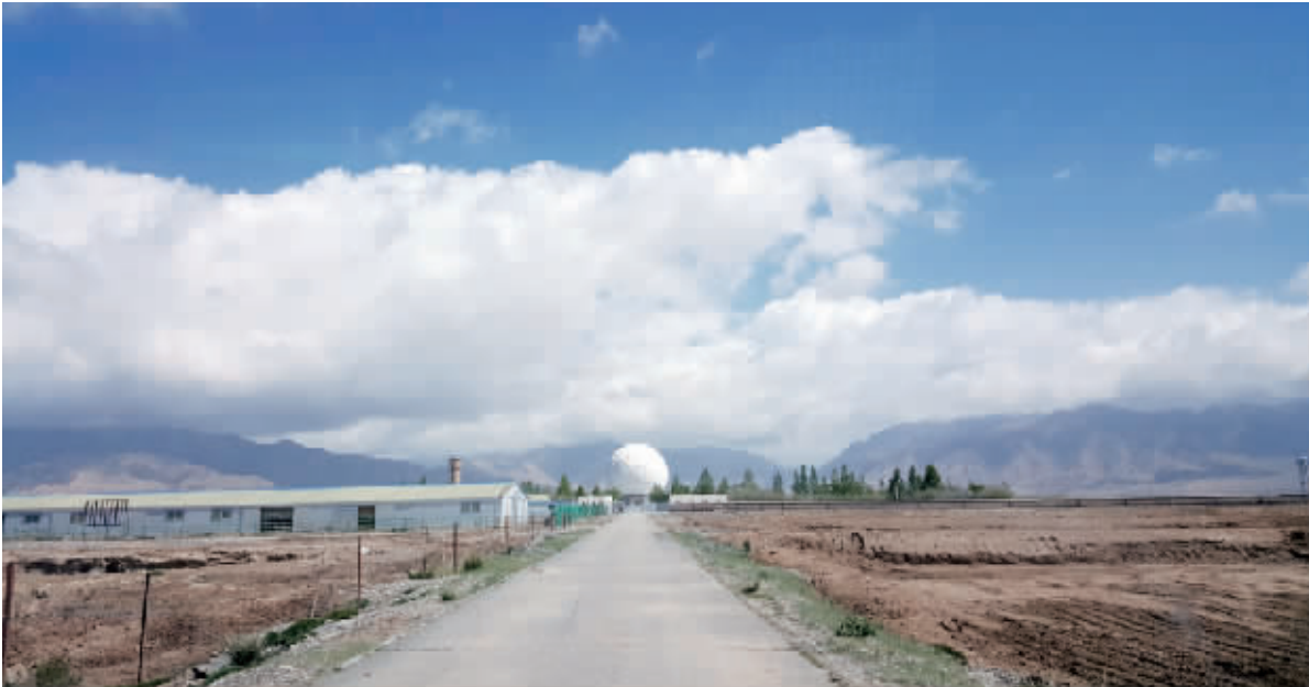
德令哈量子卫星地面站外景(6月14日摄)
