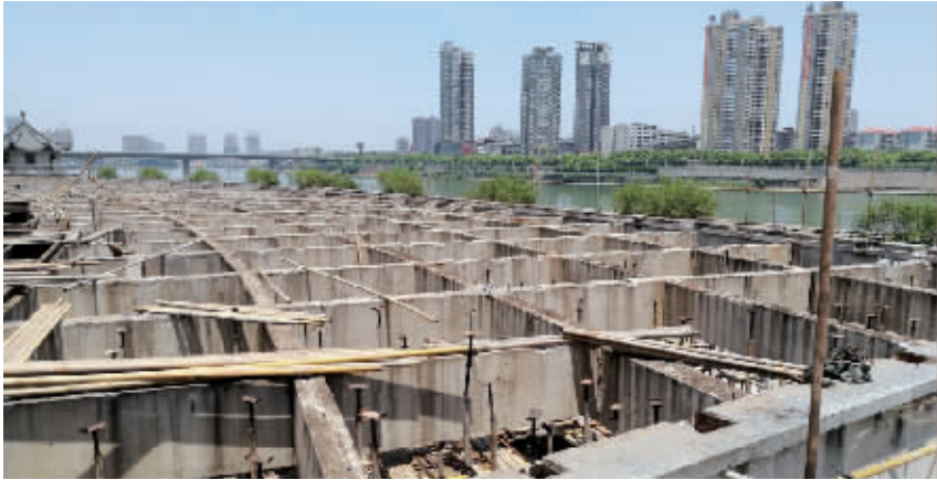
观景平台拆解成了“空架”
