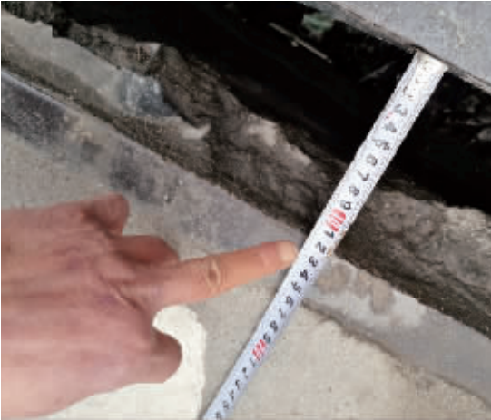
桥梁西侧伸缩缝平均宽度为 120 毫米
