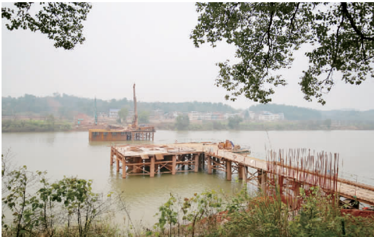
春陵水大桥打桩超过 47 根
