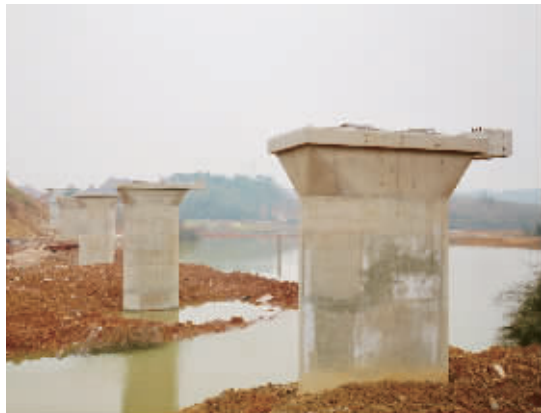
瓦松铁路 4 标段桥墩已全部完成
