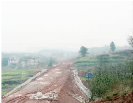
瓦松铁路路基已基本完成
