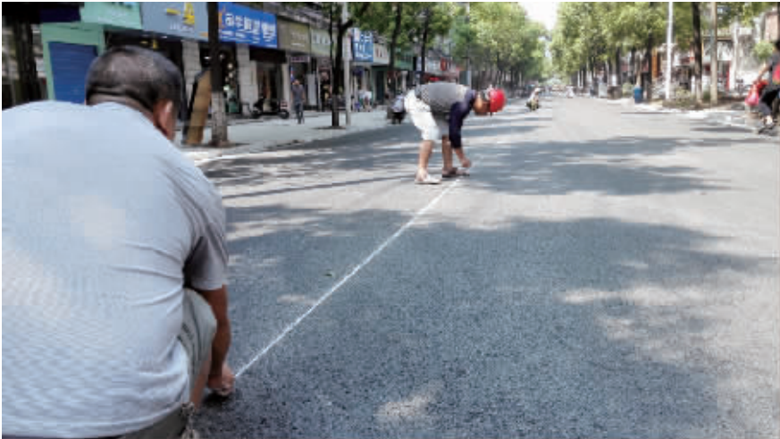
技术人员正在施划交通标线
