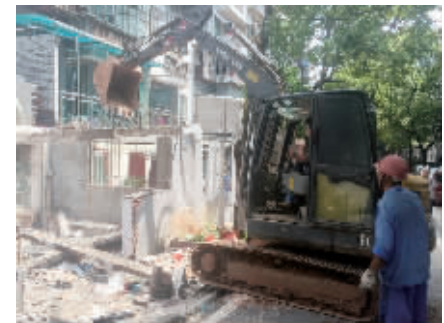
工人操作机械,正在拆除违章建筑。
