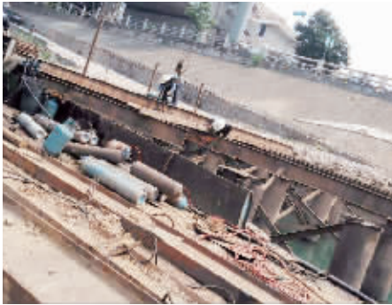
焊割槽钢火花四溅
