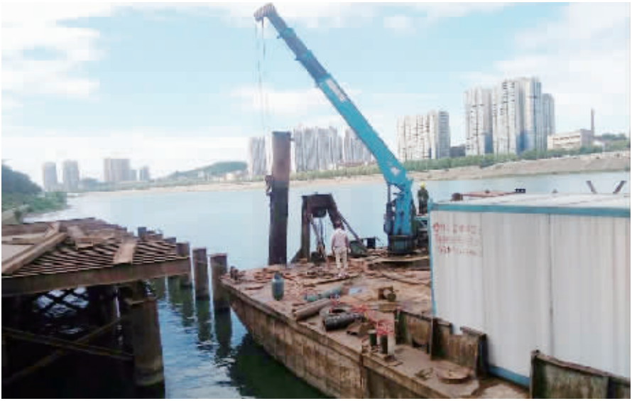
动用大型工程船清除水中碍航物
