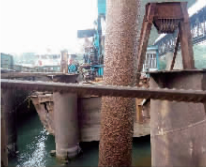
拔除水中的螺旋钢管
