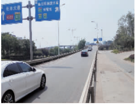
杨柳互通式立交桥车流较大
