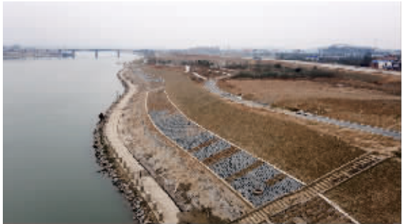
建设中的耒水东岸风光带
