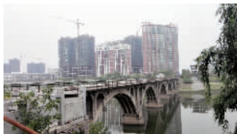
仅供步行观景的西合铁路桥
