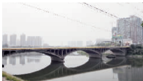
双曲石拱结构的蒸水桥
