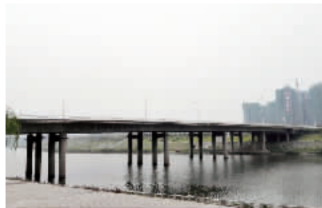
箱梁结构的铜钱渡大桥
