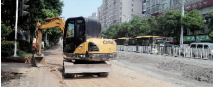
工程机械在路面上加紧施工 谢小青 摄
