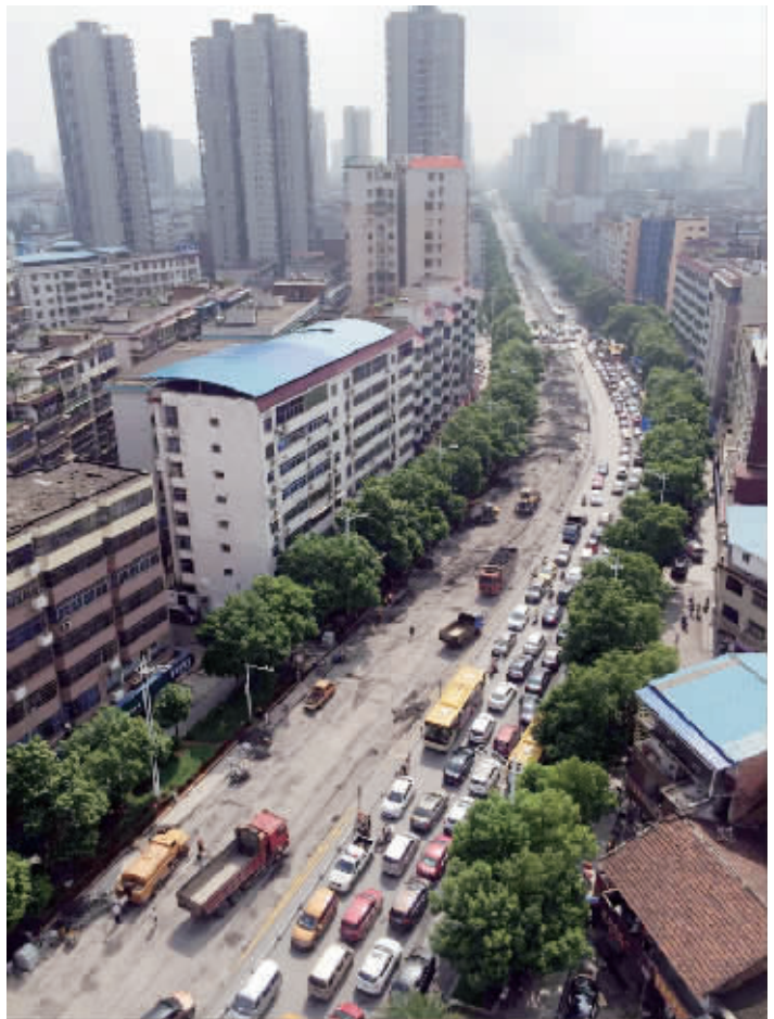
船山大道半封闭施工给城区交通带来压力 林闽 摄
