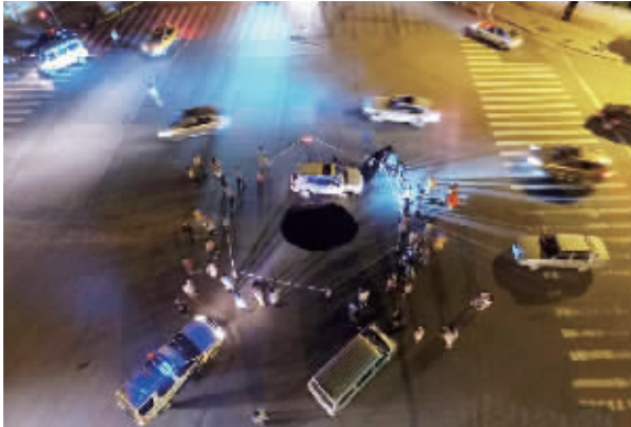
湖南长沙一主干道路面发生塌陷
