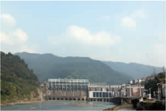
双牌电站大坝
