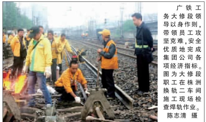
广铁工务大修段领导以身作则,带领员工攻坚克难,安全优质地完成集团公司各项经济指标。图为大修段职工在株洲换轨二车间施工现场检查焊轨作业。陈志清摄
