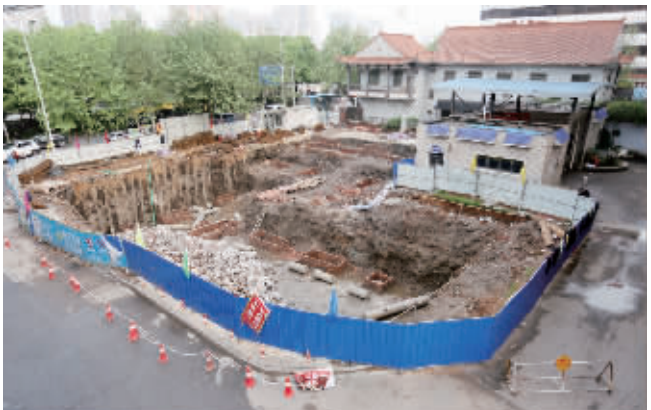
紧临船山大桥的公共停车场正在建设中 李西 摄
