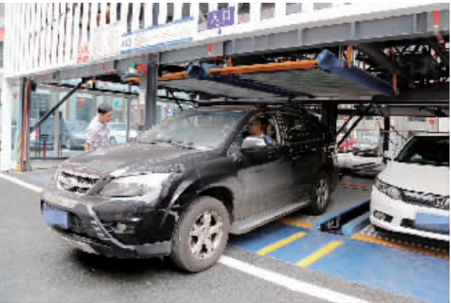
车主正在感受立体停车库 王翟 摄
