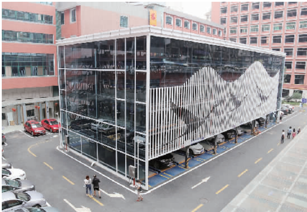
2015 年 9 月,衡阳首家立体停车库在南附二医院东院建成并投入试运行。 王翟 摄
