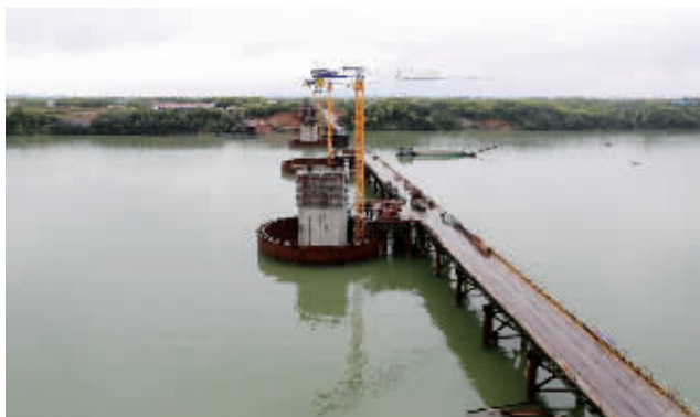
跨湘江特大桥正在建设桥墩。
