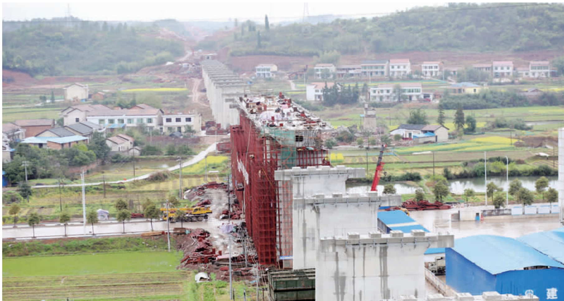
跨湘江特大桥。
