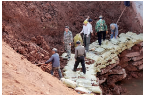
跨柿江河框架桥正在紧张施工
