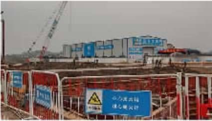
施工现场热火朝天
