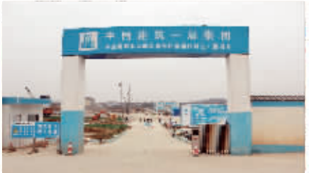
合江套湘江隧道施工工地。
