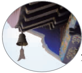
雁峰寺重建工程
