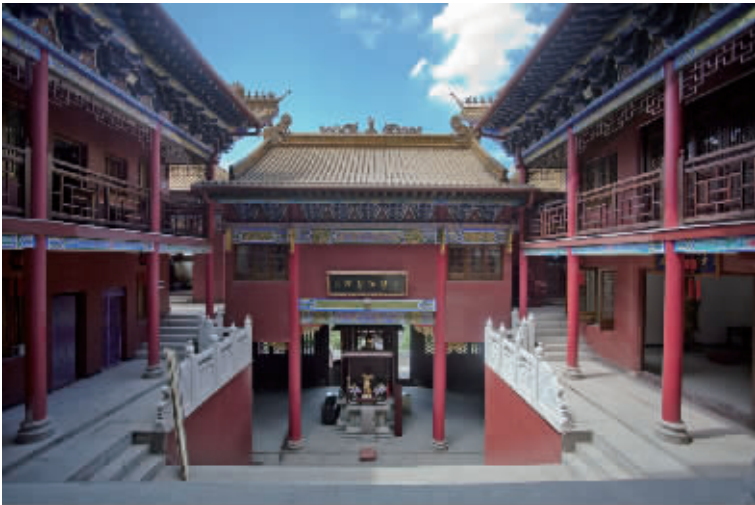
雁峰寺重建工程
