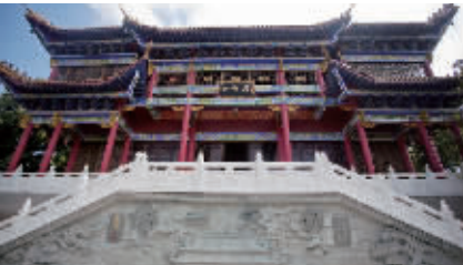
雁峰寺重建工程
