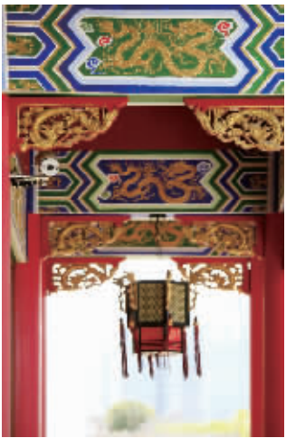
雁峰寺重建工程
