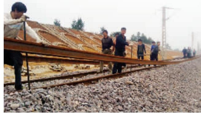
图为中铁五局六公司衡茶吉铁路铺架项目部员工正换铺长轨作业。
