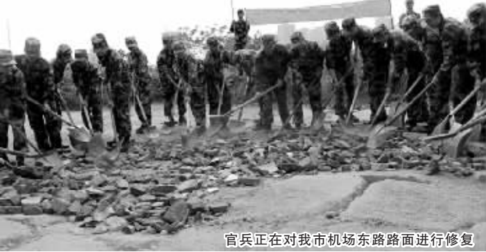
官兵正在对我市机场东路路面进行修复
