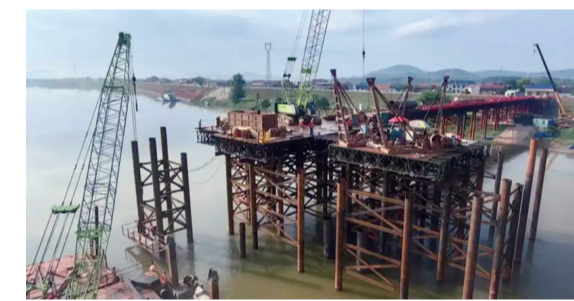
“株耒扩容”项目先行开工点——洑水特大桥。
